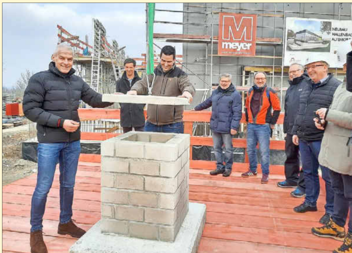
Feierlicher Moment: Bürgermeister Fred Jüngerich versenkt die Zeitkapsel in der Hallenbad-Mauer.
