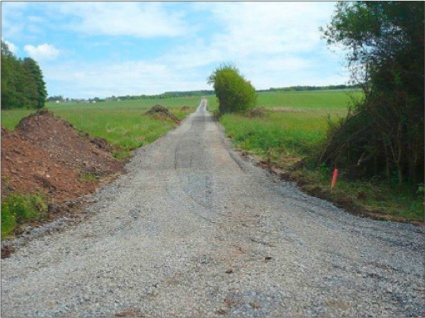
Beginn der ersten Wegebaumaßnahme im „Fluterscher Feld“
