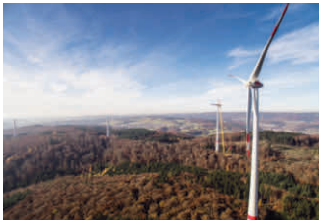
Insgesamt sieben Windräder werden in Kürze im Windpark Lahn-Dill-Bergland Mitte ihren Betrieb aufnehmen
