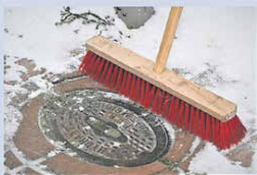
Unter diesem, in der Fahrbahn oder Gehweg eingelassenen Metaldeckel, befindet sich die Löschwasserentnahmestelle der Feuerwehr, dem sogenannten Hydranten
