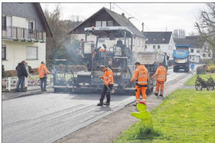
Langlebige K 9 durch effiziente Sanierung der Asphaltdeckschicht mit modernster Technik
